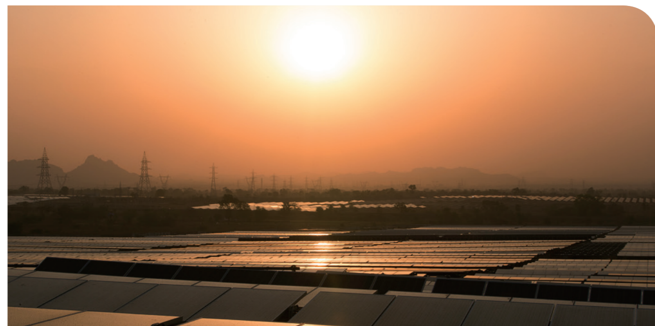
中電在印度的首個太陽能光伏電站（Veltoor）接近全面投產，使集團在印度的可再生能源組合增至約970兆瓦
