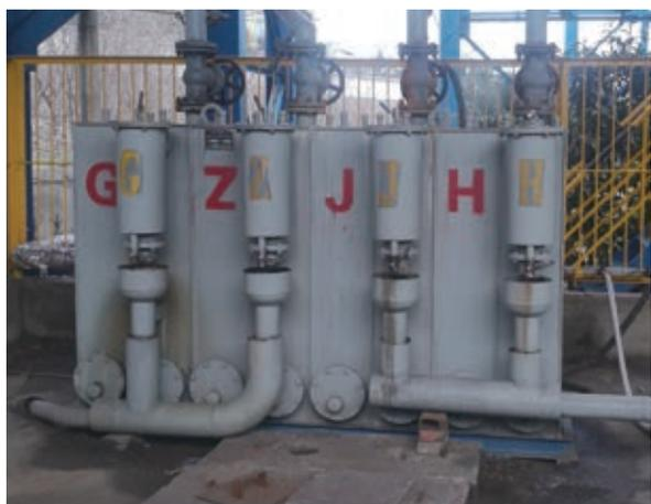
更換成防煤氣洩漏型排水器
