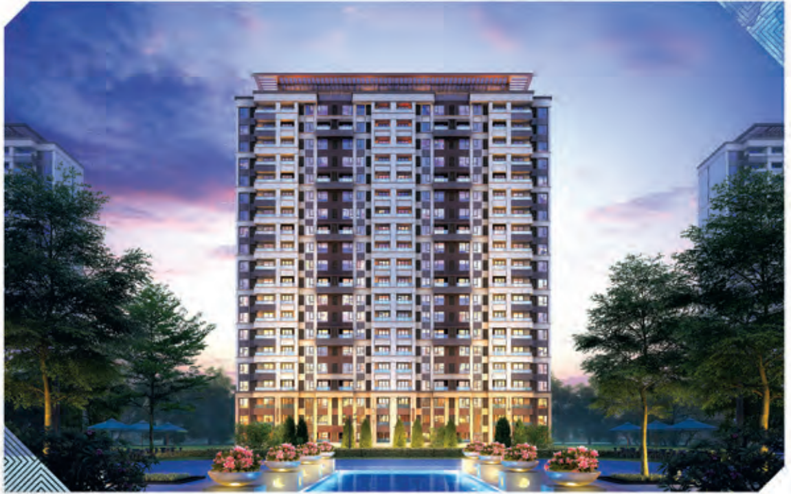
Yuzhou Suzhou Gaixin Project 禹洲蘇州高新項目
