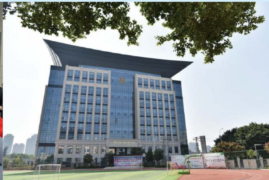
福州德旺圖書館大樓
