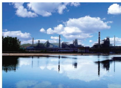
Sewage treatment station 污水處理站
