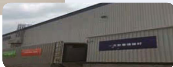
安徽合肥高新區太陽能5MW光伏電站項目並網成功
