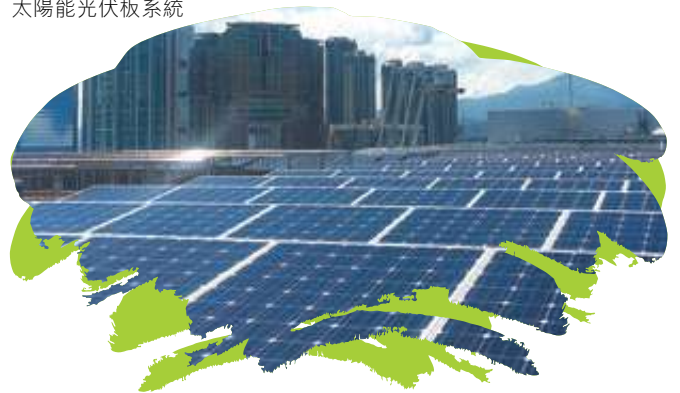
太陽能光伏板系統
