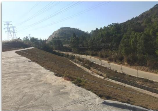
徑南工業園項目為穩定路基及減少水土流失，在工程初期，設計了混凝土澆築及植草處理的護坡防土牆及明溝。
