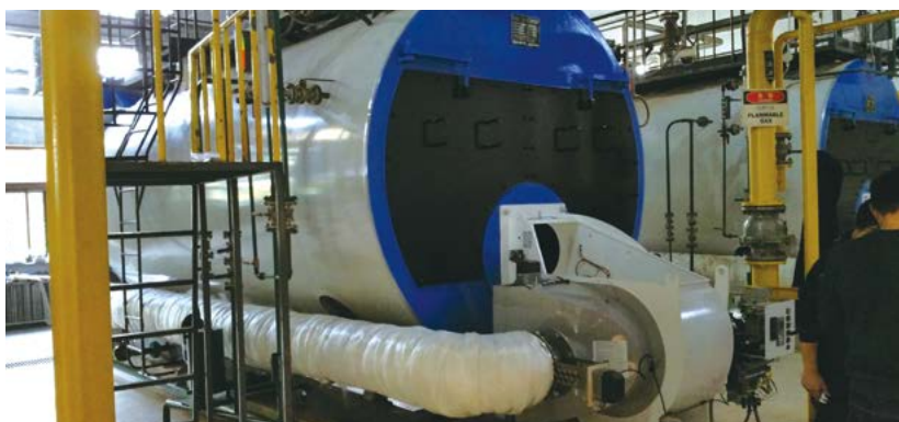
華潤紫竹天然氣鍋爐超低氮燃燒改造
