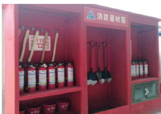
圖6：施工現場消防器材箱
