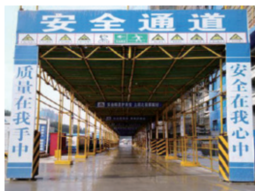
圖7：施工現場主幹道安全通道
