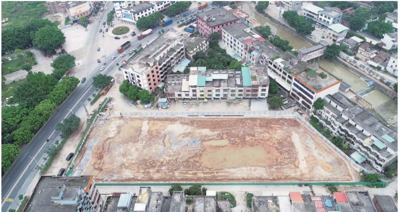
惠州博羅縣住宅發展項目之地塊，現正進行基坑工程
