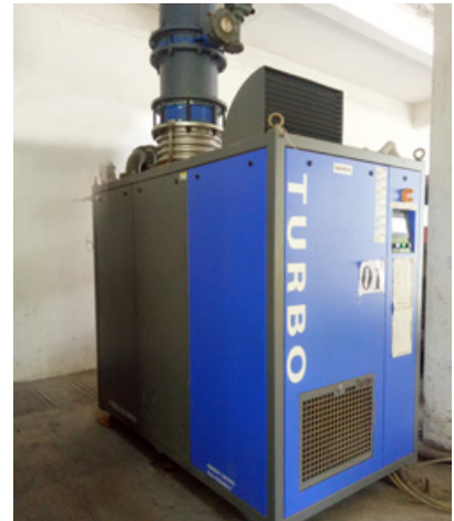
Air suspension blower 空氣懸浮鼓風機
