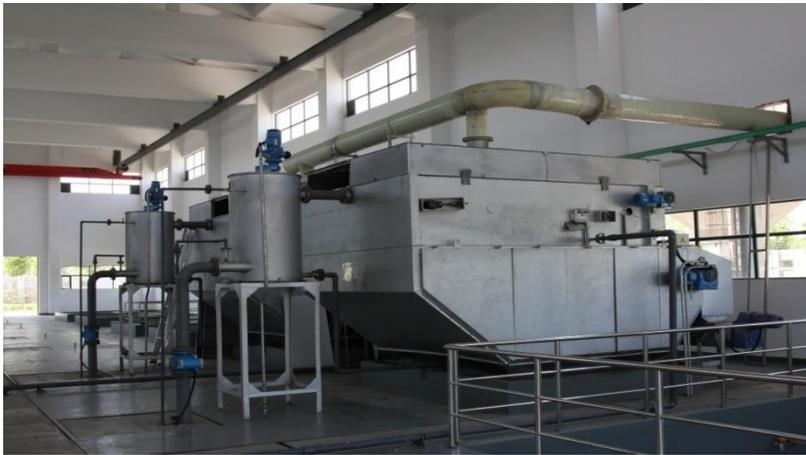
圖 18: 青浦第二污水處理廠項目的污泥脫水裝置
