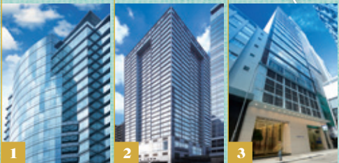
1 The Metropolis Tower 都會大廈
