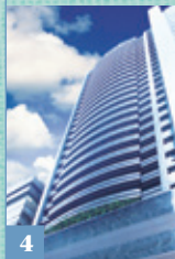
4 Prosperity Place 泓富廣場
