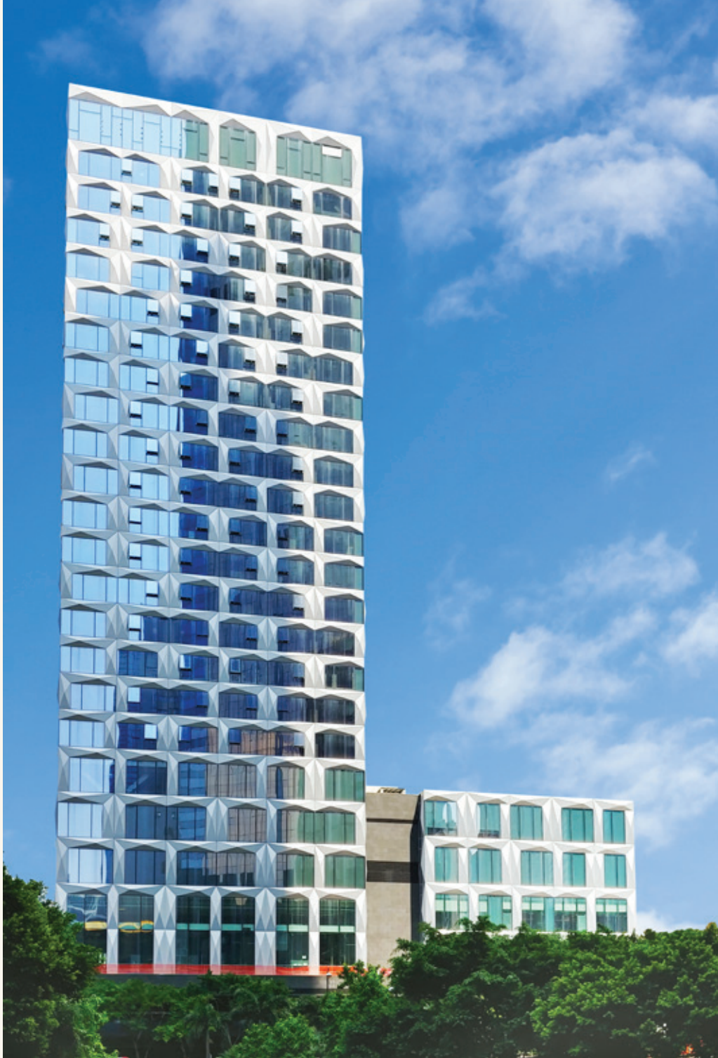
China Resources St. Regis Hong Kong facade project 香港華潤瑞吉酒店玻璃幕牆項目
