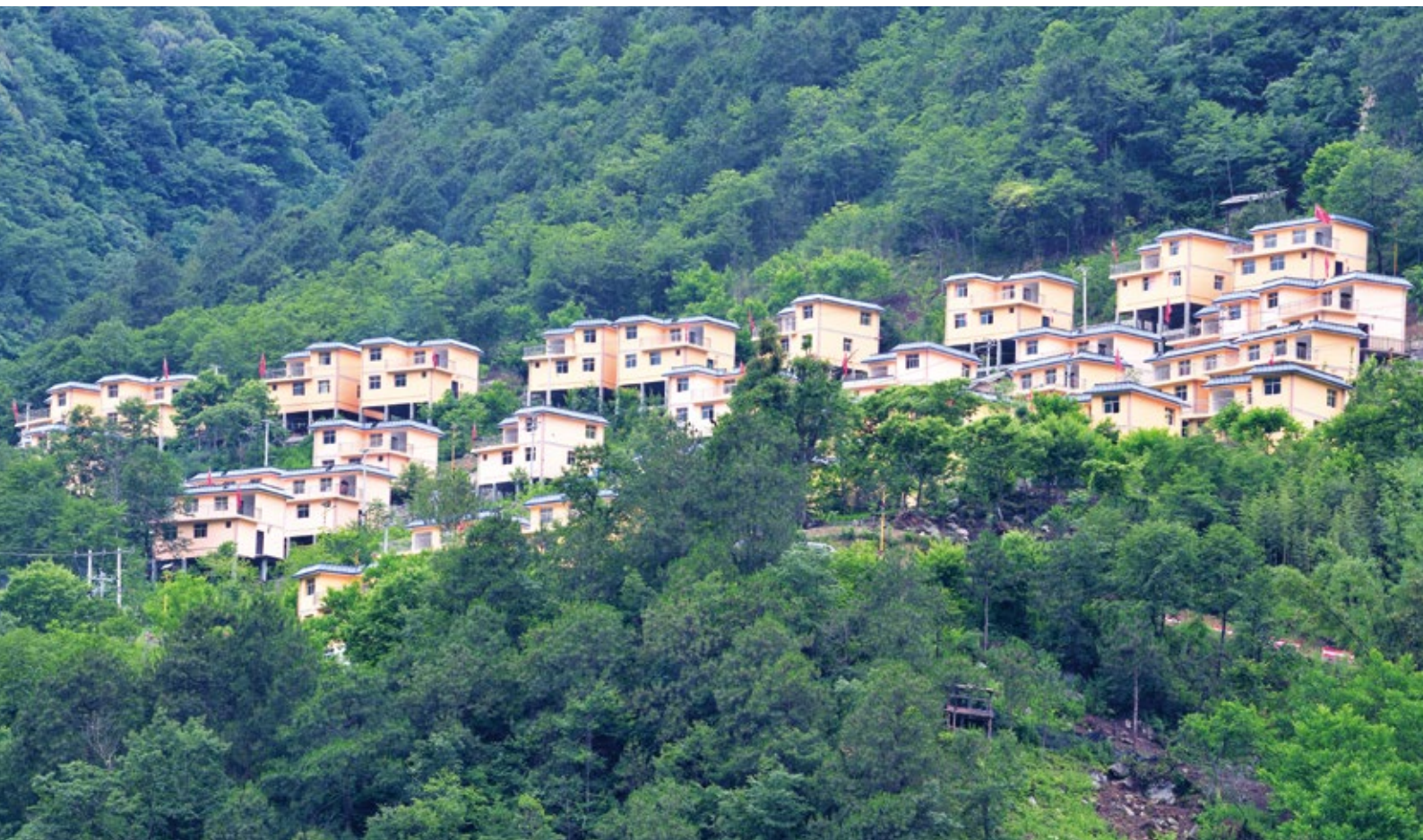
▲ 怒江易地扶贫搬迁安置点
