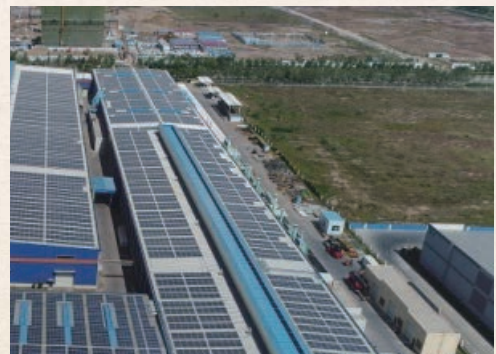
青島冷藏箱基地光伏電站
