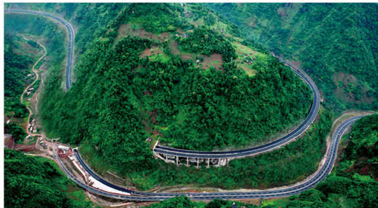
本行融資支持的水麻高速公路項目首創螺旋展線橋樑路段
