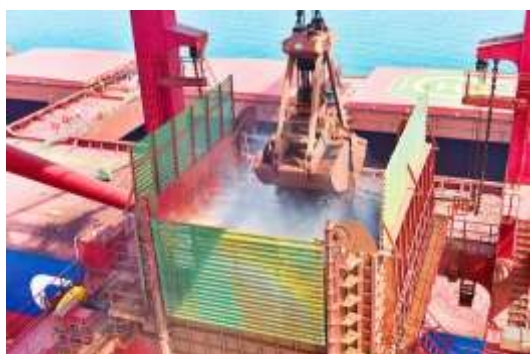
卸船机自动化抑尘系统
