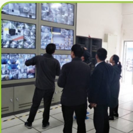
Equipment Room Open Day 設備室開放日
