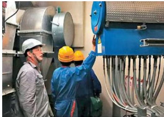
2018 年 9 月 16 日，大亞灣核電基地值班人員檢查廠房貫穿件
