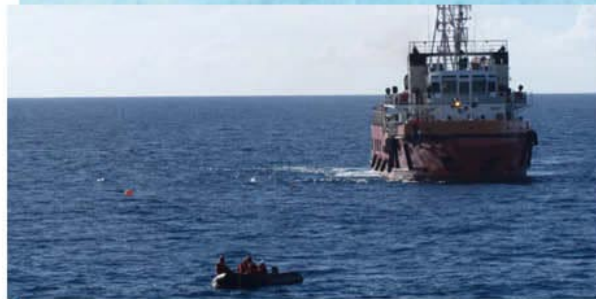
渤中 19-6 凝析氣田海底電纜寬方位地震採集開工
