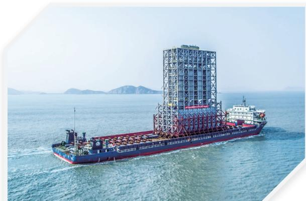
浙江石化140萬噸／年乙烯裝置裂解爐項目單台裂解爐整體模塊交付
