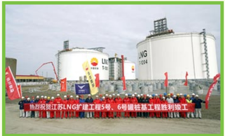
江蘇LNG接收站三期工程樁基工程完工
