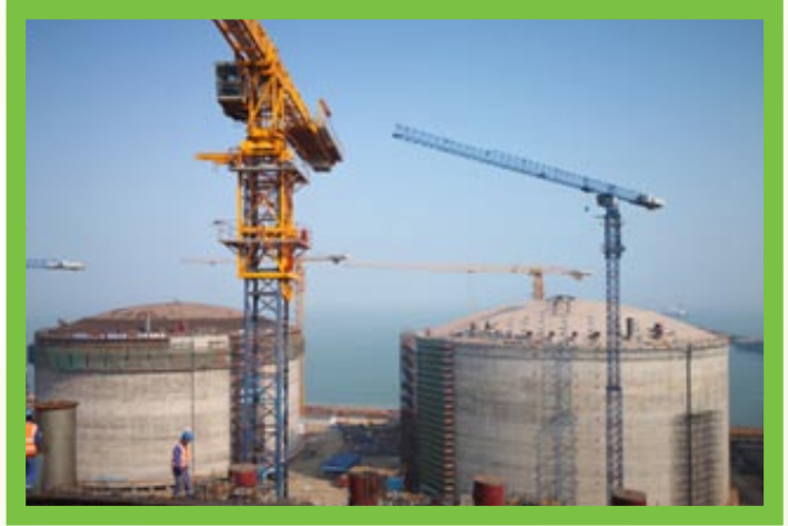
唐山LNG接收站應急調峰保障工程總體進度近半
