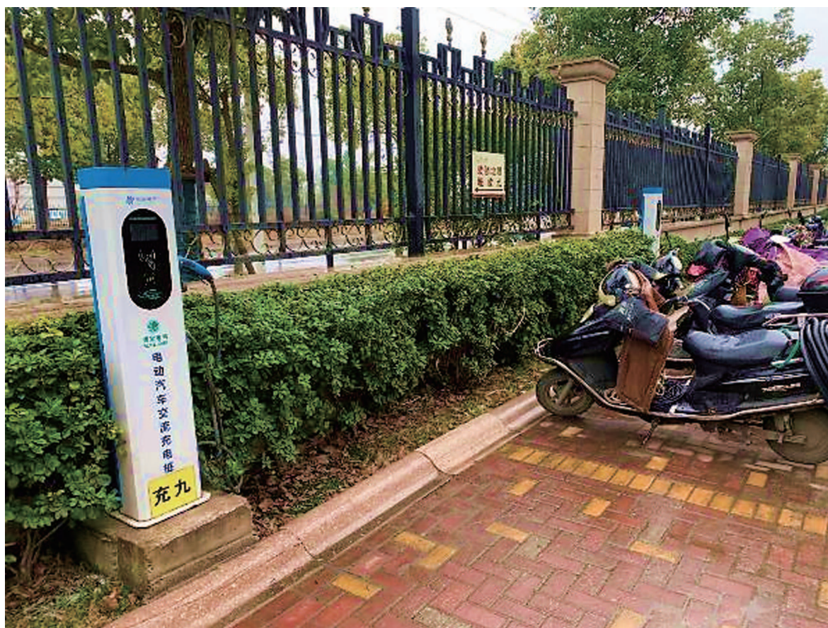
設置於天璽灣項目的電動汽車交流充電樁
