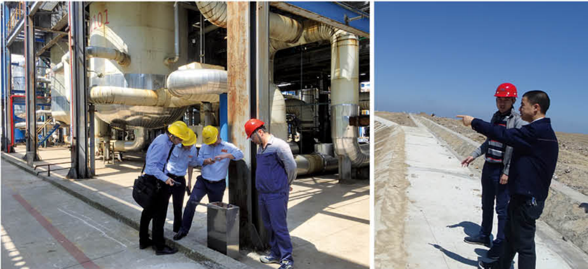
重慶分公司開展 2018 年汛期防災防損檢查工作現場
