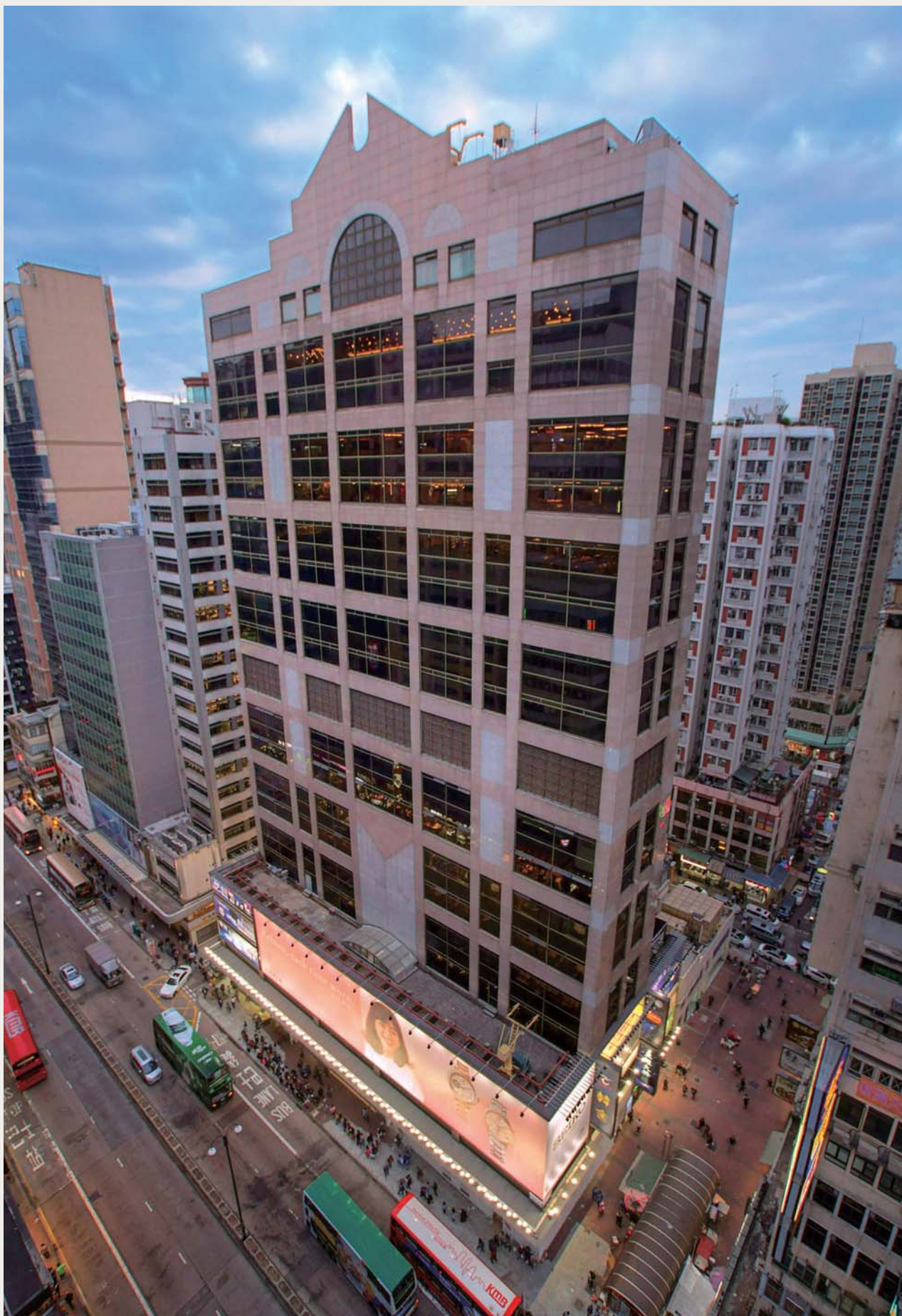
Chong Hing Square 創興廣場
