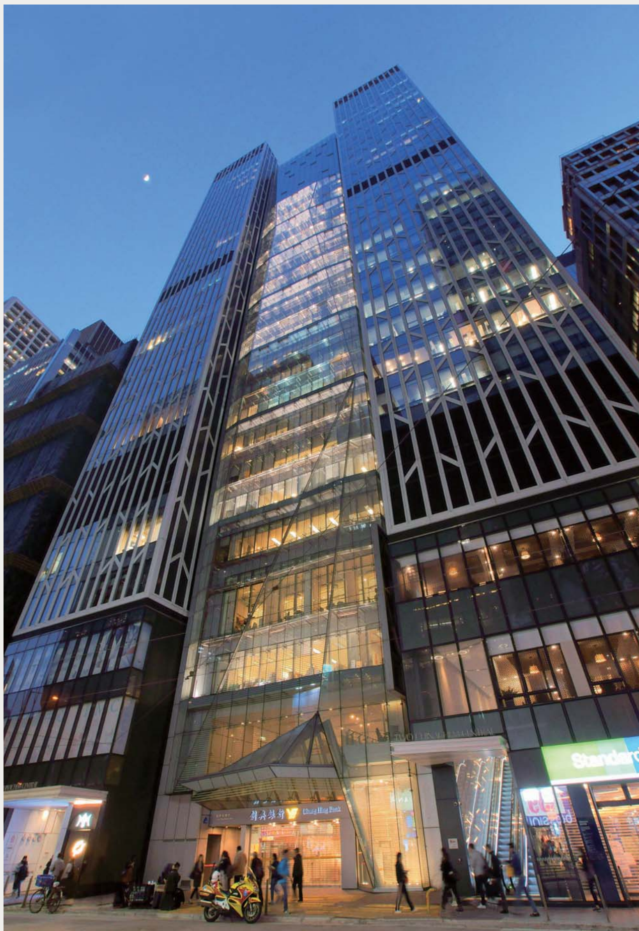
Chong Hing Bank Centre 創興銀行中心
