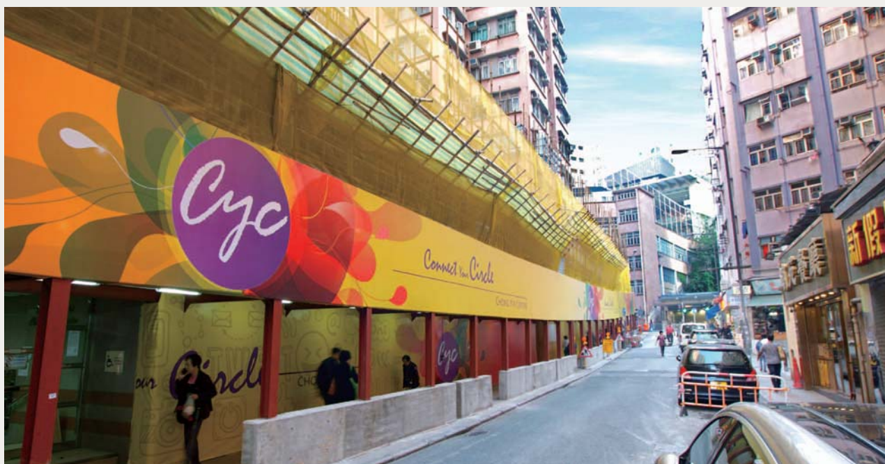
Chong Yip Centre under renovation 創業中心翻新進行中
