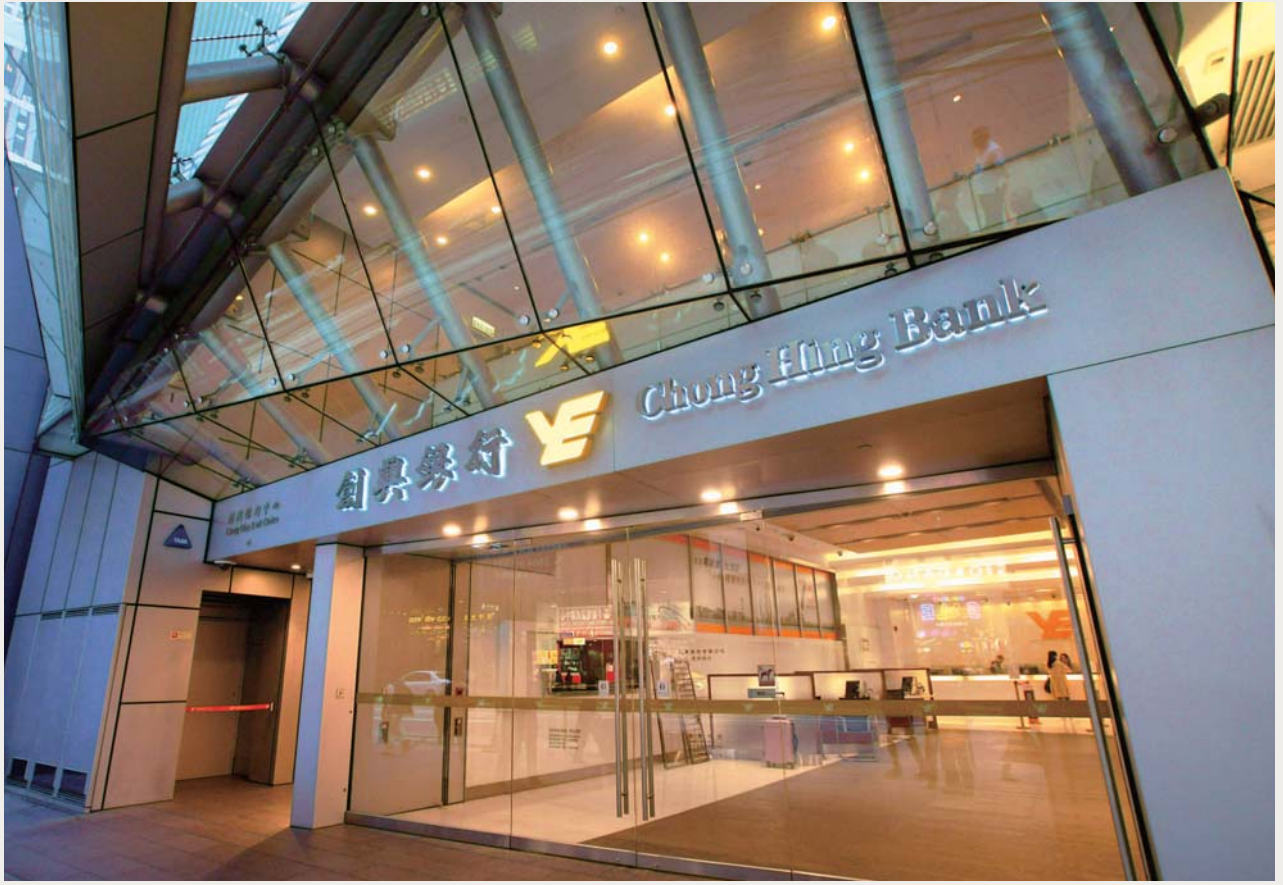
Chong Hing Bank Centre 創興銀行中心
