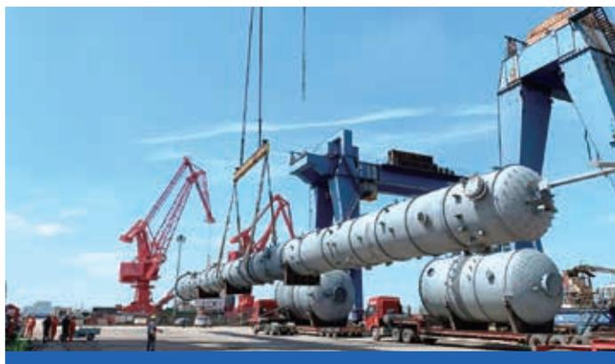
三台反應器為攪拌反應容器，單台重量110噸，裂解氣氣相乾燥器單台重量250噸，該設備結構特殊，技術要求非常高。
