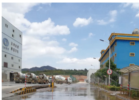
Road spraying system 道路噴淋系統
