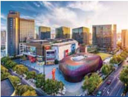
上海LCM項目 Shanghai LCM Project
