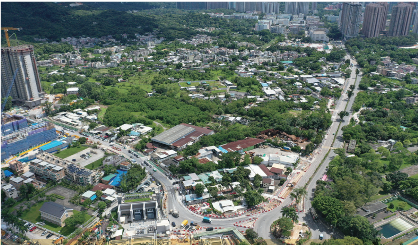
Queen's Hill Development — Road and Drainage Works 皇后山發展 — 道路及渠務工程
