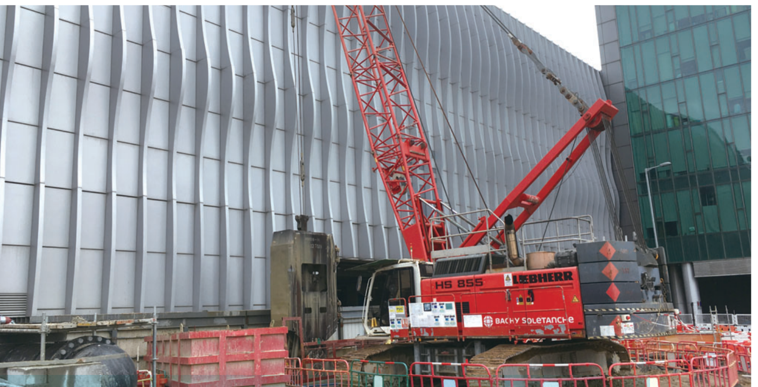
Hong Kong International Airport — Terminal 2 Foundation and Substructure Works 香港國際機場 — 二號客運大樓地基及下層結構工程
