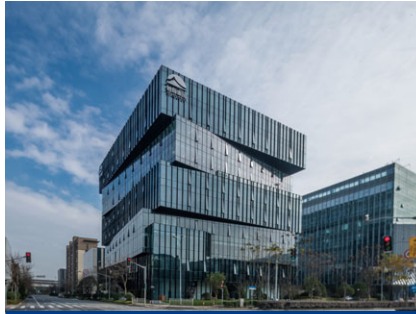
上海恒基旭輝中心 Shanghai Henderson CIFI Center
