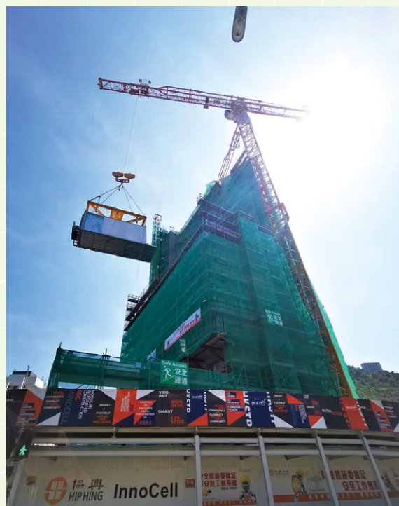
香港科學園創新斗室的建設階段
