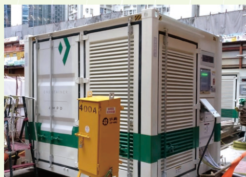
在建築工地使用「淨能櫃」
