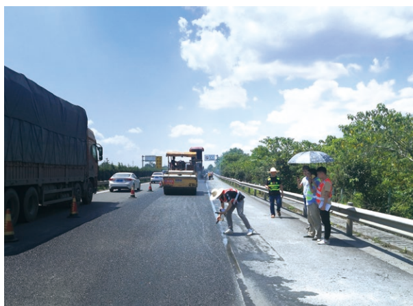
嘗試以瀝青混合舊輪胎物料修路
