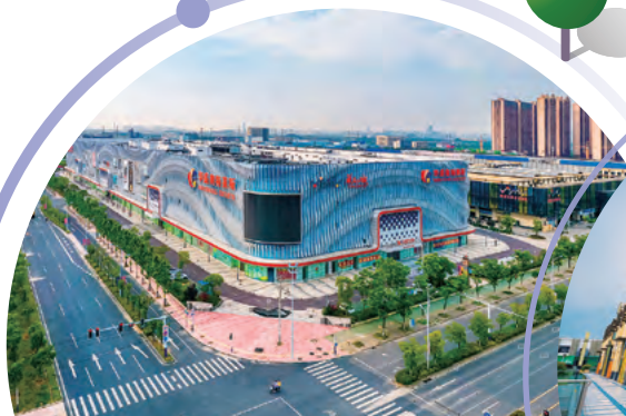
Outlets in CSC Hefei 於合肥華南城的奧特萊斯
