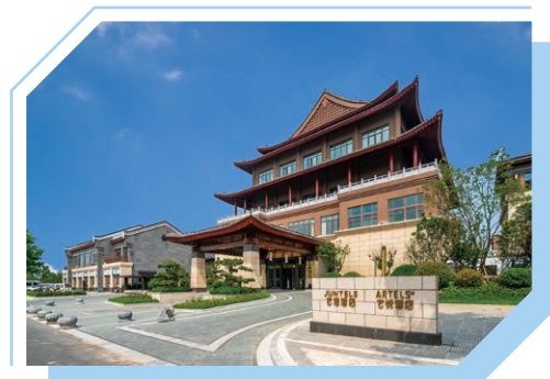
ARTELS+ AND JUNTELS PENGLAI YANTAI
