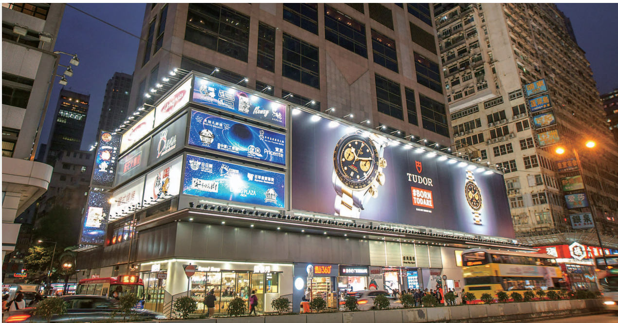
Chong Hing Square 創興廣場
