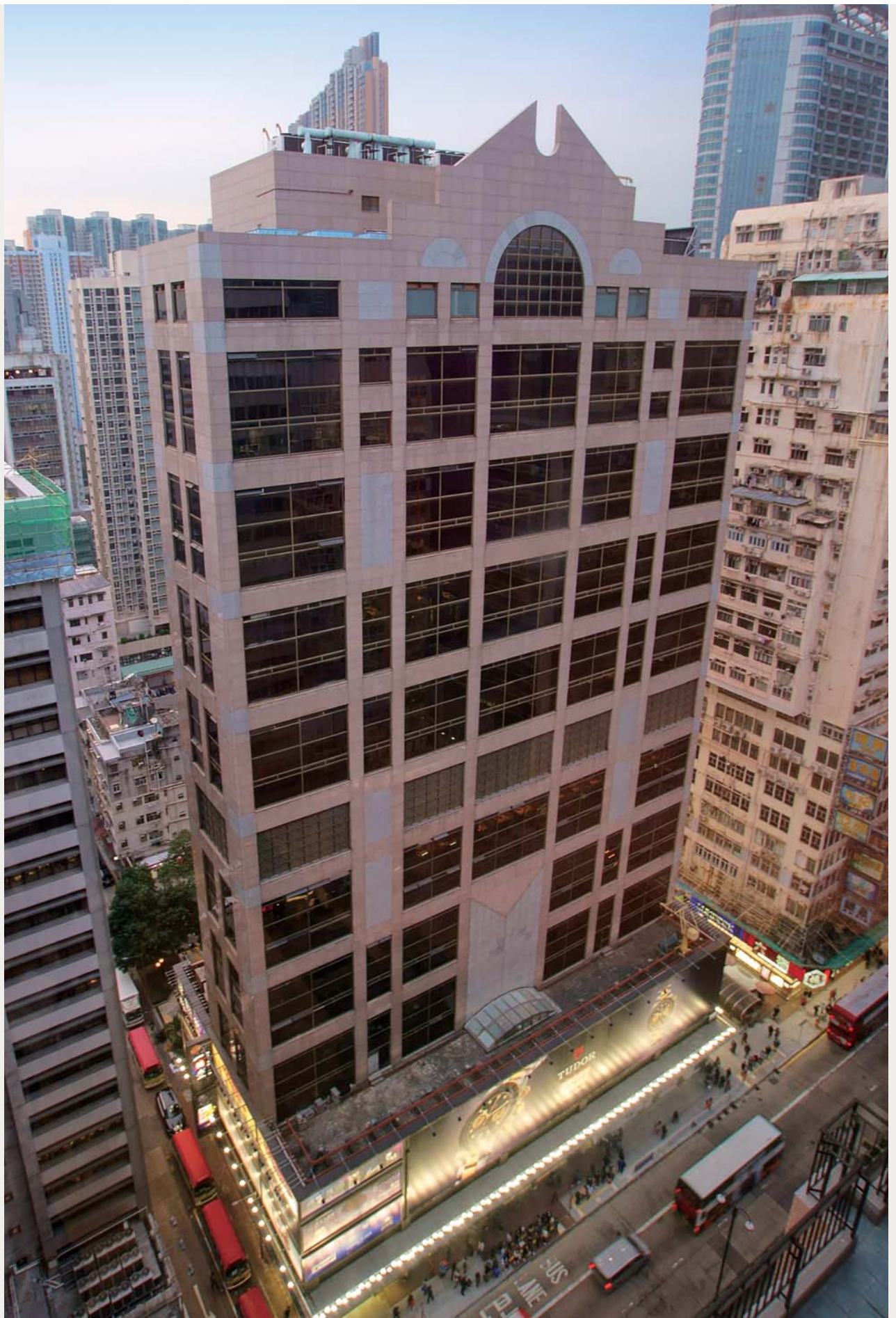
Chong Hing Square 創興廣場
