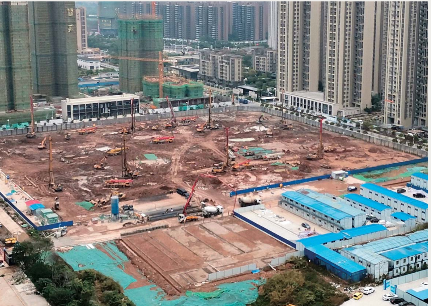
Elegance Garden, Sanshui, Foshan project in progress 佛山三水軒隆雅園工程進行中
