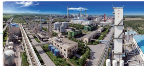
Dingzhou, Hebei 河北定州
