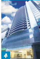
4 Prosperity Place 泓富廣場
