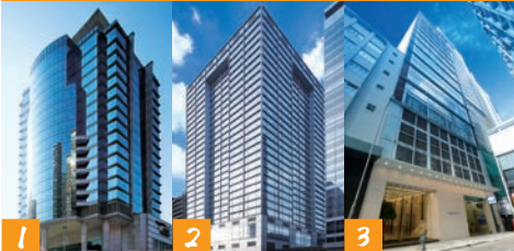
1 The Metropolis Tower 都會大廈
