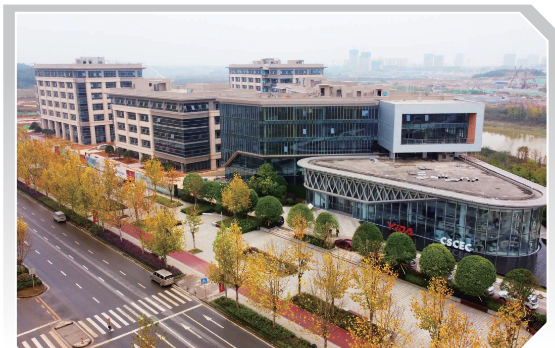
長沙億達中建•智慧科技中心
