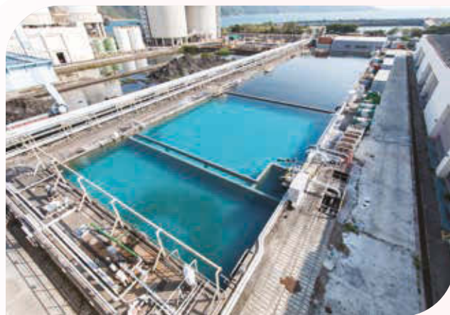
南丫發電廠將收集得來的雨水和工廠廢水循環再用。
