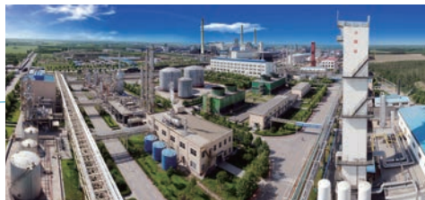
Dingzhou, Hebei 河北定州
