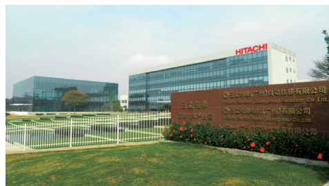
日立電梯高新技術產業園 Hitachi Elevator Hi-tech Industrial Park
