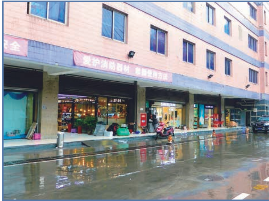
Entrance at G/F, Guang Yu Square 港渝廣場地下入口
