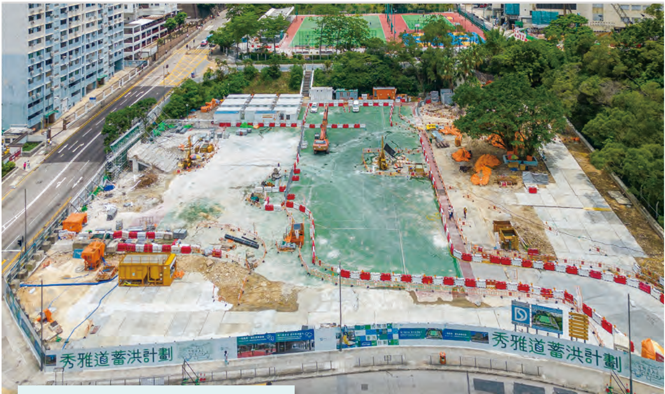
Sau Nga Road Stormwater Storage Scheme 秀雅道地下蓄洪計劃
