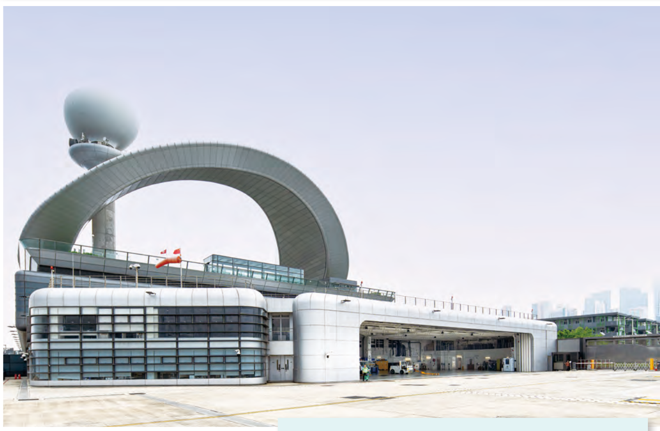
Construction of Government Flying Service Kai Tak Division 政府飛行服務隊啟德分部建造工程
