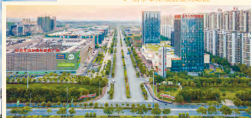
▼ Birdview – CSC Nanning Project Site ▼ 南寧華南城區鳥瞰圖
