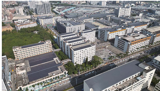
Solar Energy Project on Factory 廠房太陽能項目
