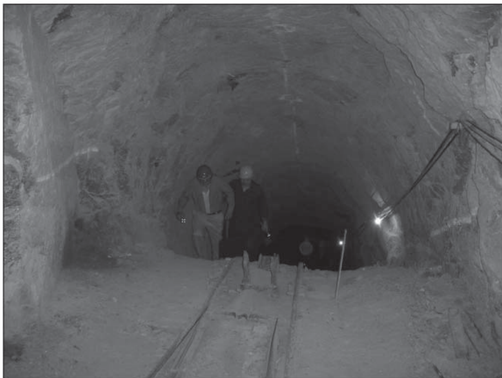
井筒／通往溶區的在建起吊巷道
