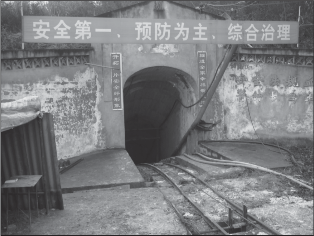
礦石提升斜井入口
