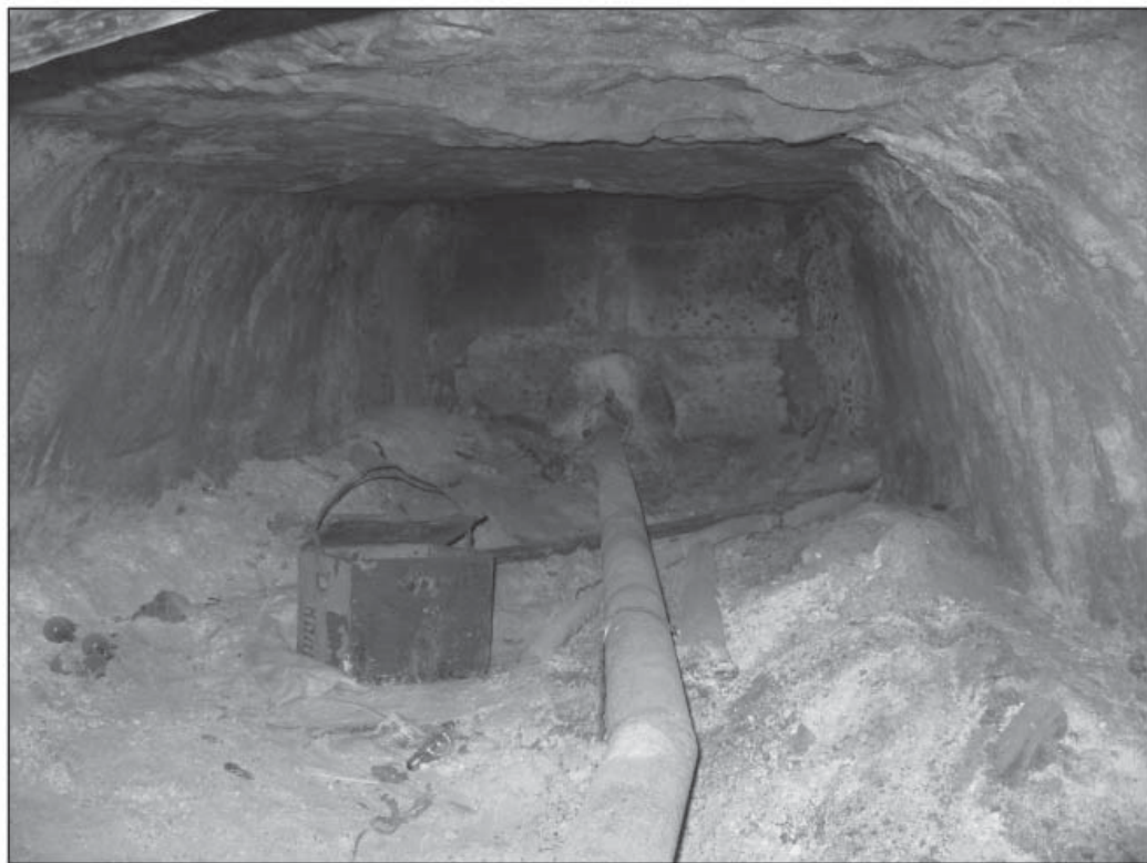
廢棄溶區溶液排放點
