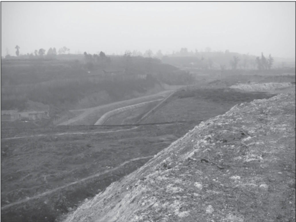
場地籌備區 山谷導流管建設
