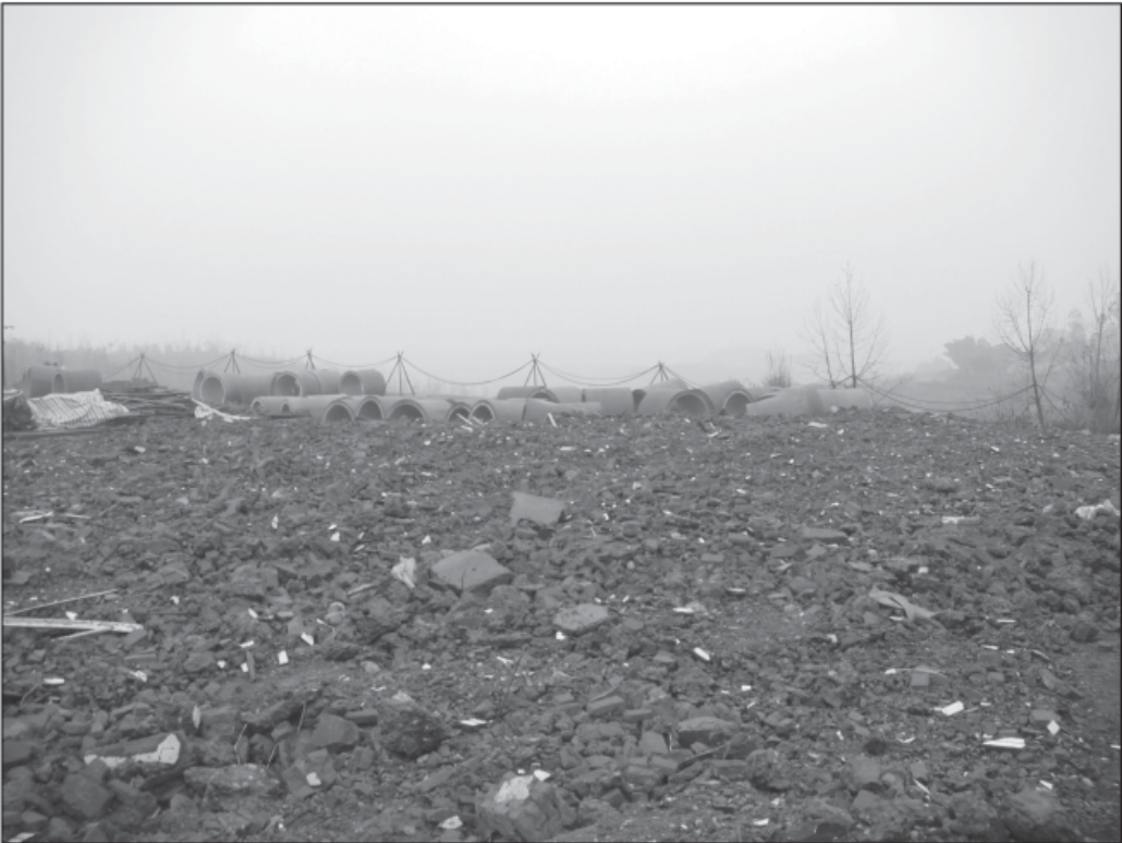
地面設施區 (已拆毀舊廠房及樓宇)
