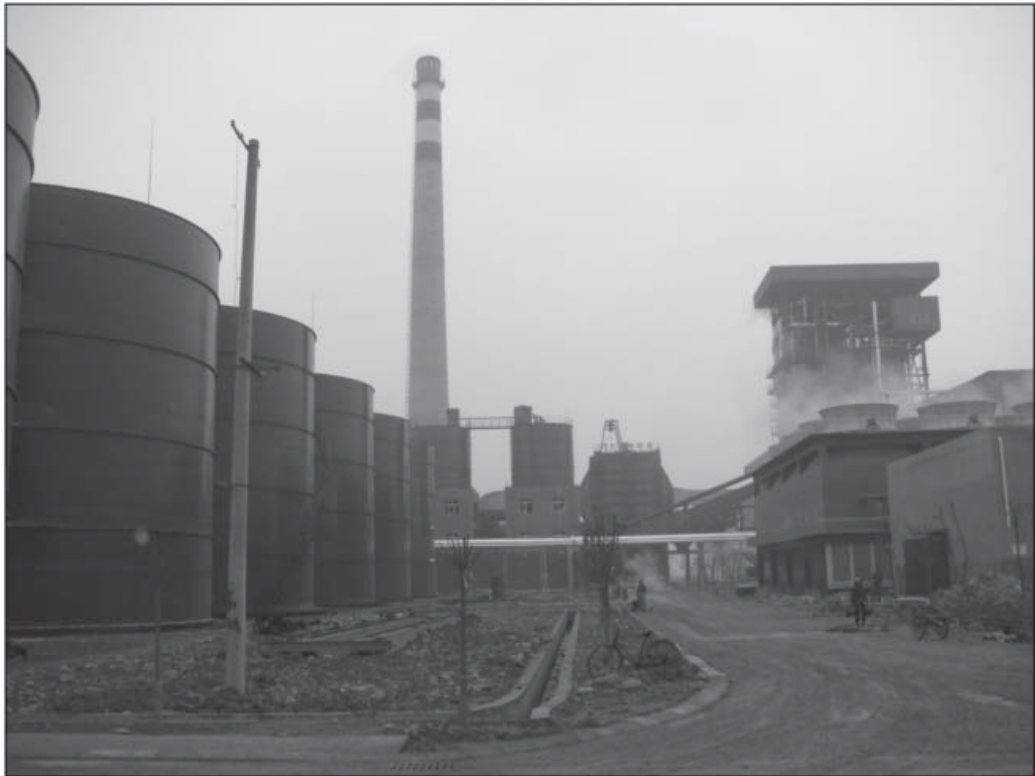
電廠／水處理設施
