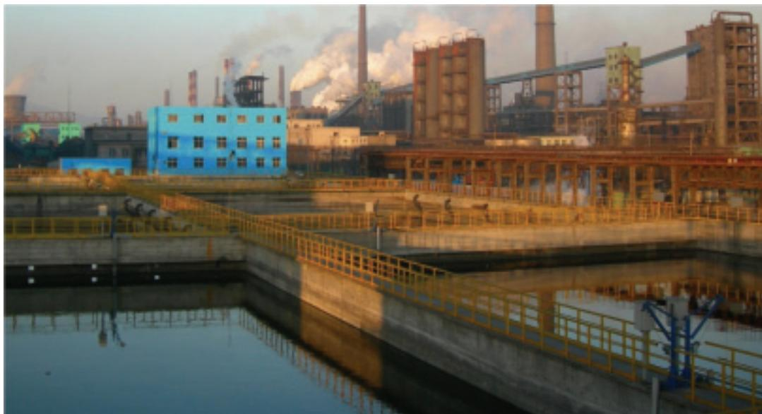
吉林鋼鐵有限責任公司的供水及污水處理項目為大型工業鋼鐵廠的全面綜合解決方案。該項目是展示我們為工業供水及污水處理提供綜合一站式解決方案的能力的典範。該項目涉及設計及建造工業供水處理設施(其生產新水能力為每日80,000噸，除鹽水處理能力為每日11,000噸，回用水處理能力為每日20,000噸，生活污水處理能力為每日2,500噸)、污泥處理系統及焦化廢水處理中心。
