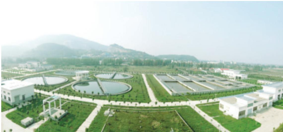
項目位於湖北省襄樊市襄城區，涉及設計及建造具備每日100,000噸污水處理能力的污水處理設施。處理程序採用A<sup>2</sup>/O預先脫氮技術。
