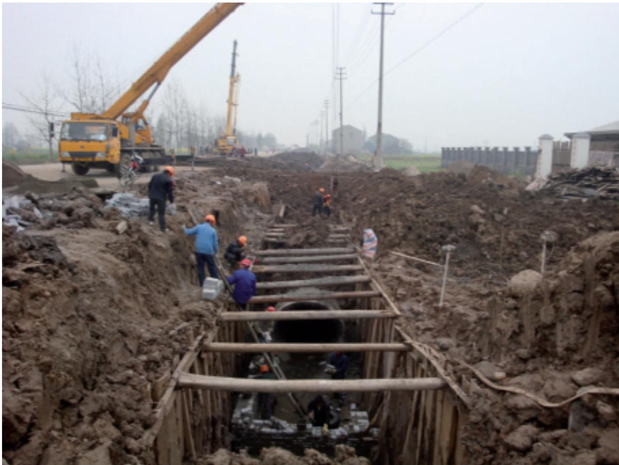
該項目專為建設連接湖北省荊州市城南污水處理廠與商業區的水管系統而設。該項目主要包括安裝污水管、雨水管、道路建設及連接位於中國荊州市草郊路、荊李路及人民南路的泵站。
