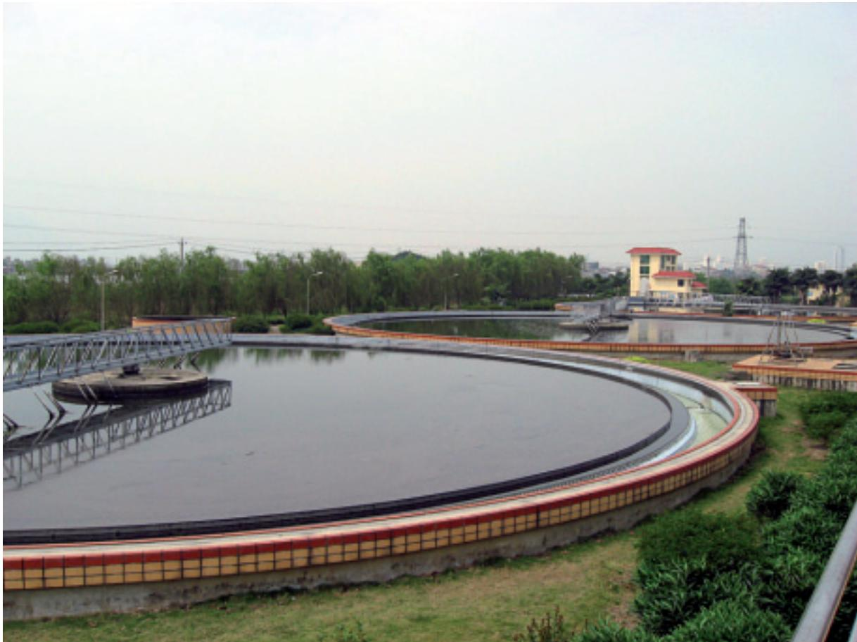
此項目位於中國福建省莆田市城廂區與涵江區結合部的東墩村及顯應村，涉及設計及建造污水處理能力在短期內達到每日80,000噸及長遠達到160,000噸的污水處理設施。處理程序採用經改良的氧化溝技術。
