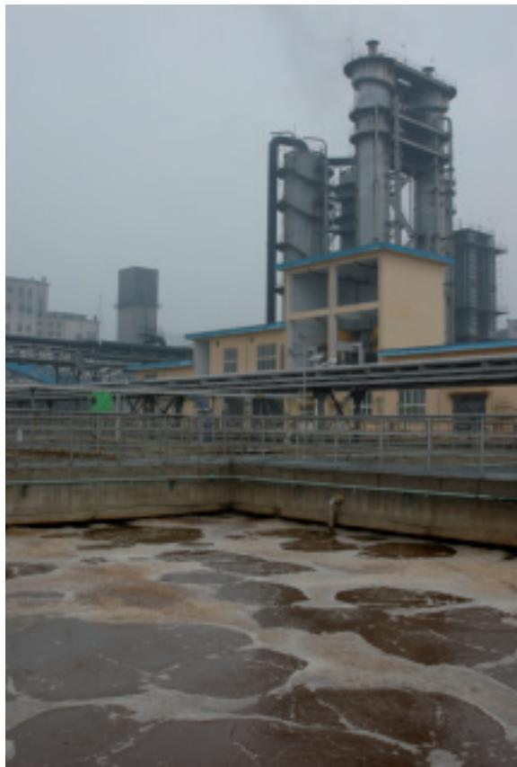
此於河北省邯鄲市的工業污水項目採用物理化學處理技術，配備具有外部淤泥加強絮凝功能、斜管沉澱技術和污泥濃縮處理功能的高效沉澱池、高效石灰軟化沉澱池及一個V型過濾池。此項目的每小時處理能力為3,000噸。
