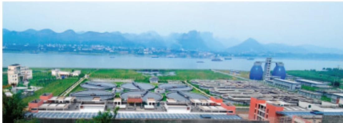
項目涉及設計及建造每日處理440,000噸水的供水處理設施、每日處理200,000噸污水的污水處理設施，並鋪設湖北省宜昌市部分水管網絡系統。供水處理廠為人口超過4,000,000的整個宜昌市提供自來水。
