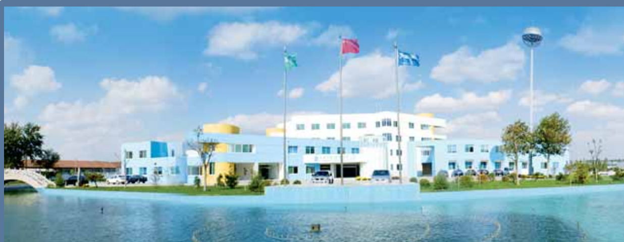
Zibo Waste Water Treatment Project 濰博污水處理項目
