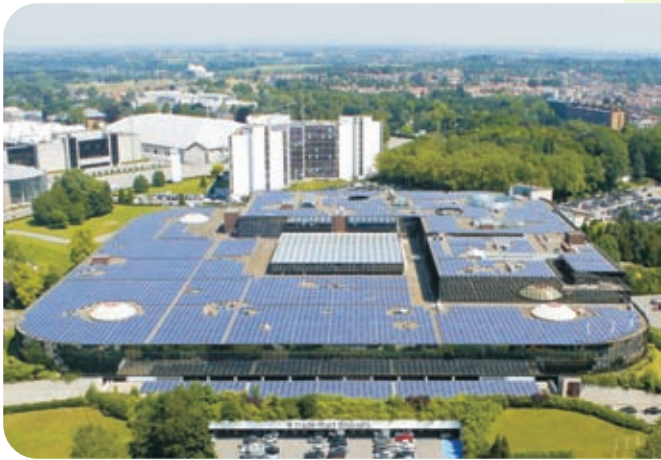
比利时最大的屋顶光伏系统
